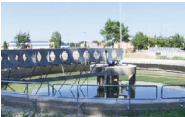
Stația de epurare: decantor primar reabilitat
