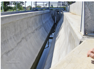
Stația de epurare: deznisipator reabilitat
