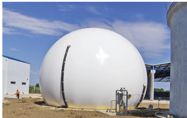
Stația de epurare: rezervor nou pentru acumularea gazelor rezultate din procesul de fermentare a nămolului (gazometru)
