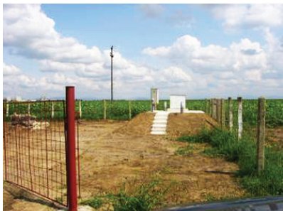
Puț de captare a apei reabilitat
